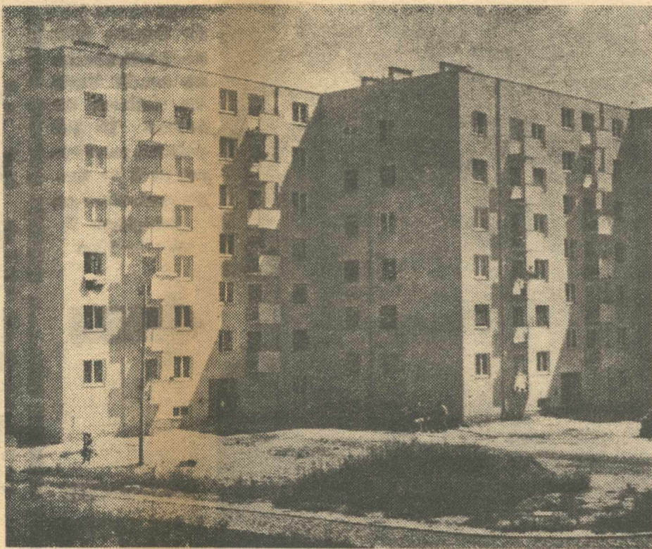
NIČU ZGRADE, ALI I — PROBLEMI
